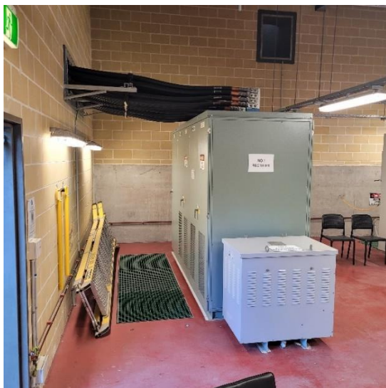
Figure 4.3.1a Rectifier Diode Cubicle
